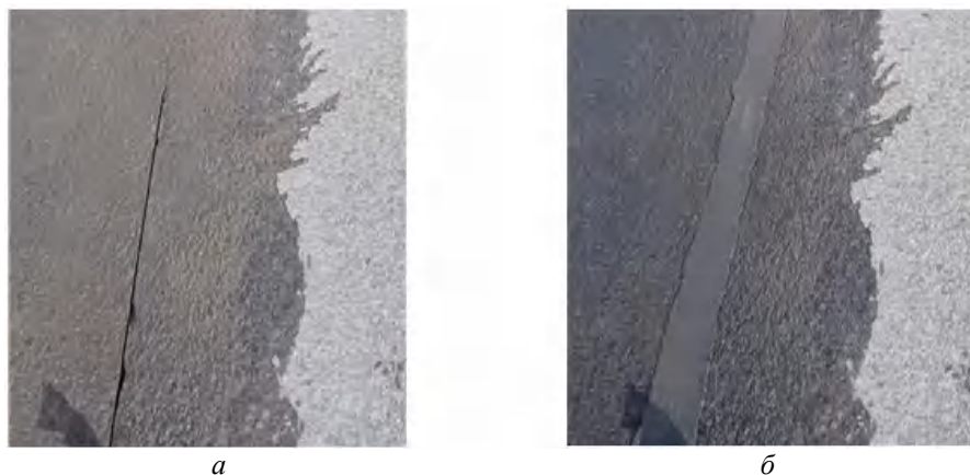
Рис. 3. Этапы проведения работ на объекте: а – начальный этап проведения работ, б – заключительный
